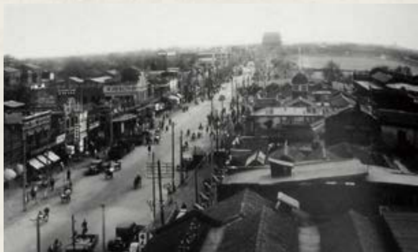
183. 远景是王府井南口牌楼和意大利兵营通讯塔。
